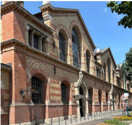
Die Fassade der Markthalle ist mit bunten, glasierten Ziegeln aus der Porzellanmanufaktur Zsolnay eingekleidet
