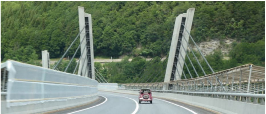
Auf der Sunnibergbrücke bei Klosters
