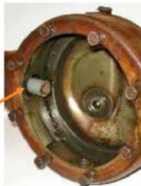
Foto vom Innern der Achse bei ausgebautem Achsantrieb !
