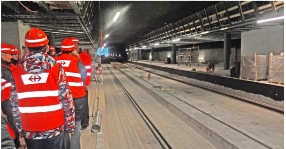
Auf der Baustelle des unterirdischen Bahnhofs Löwenstrasse
